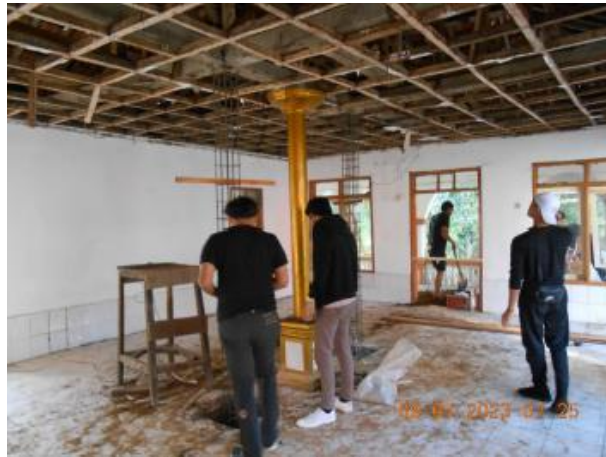
Gambar 8. Pekerjaan pembuatan tiang untuk perkuatan atap
